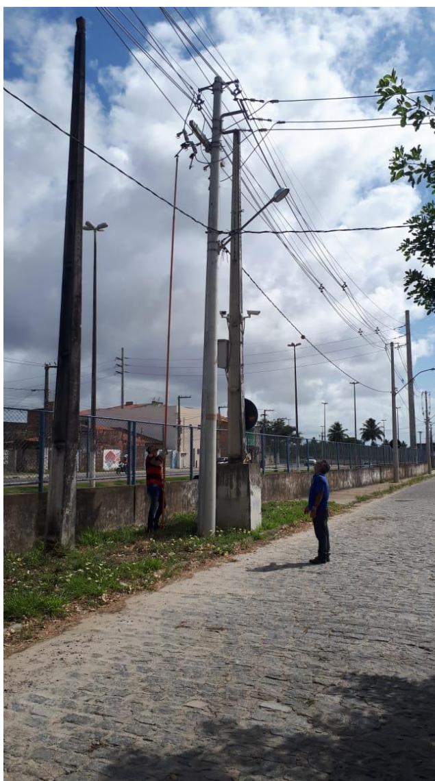
Figura 01 – Equipe da DIMEC realizando manutenção corretiva na chave fusível danificada.
