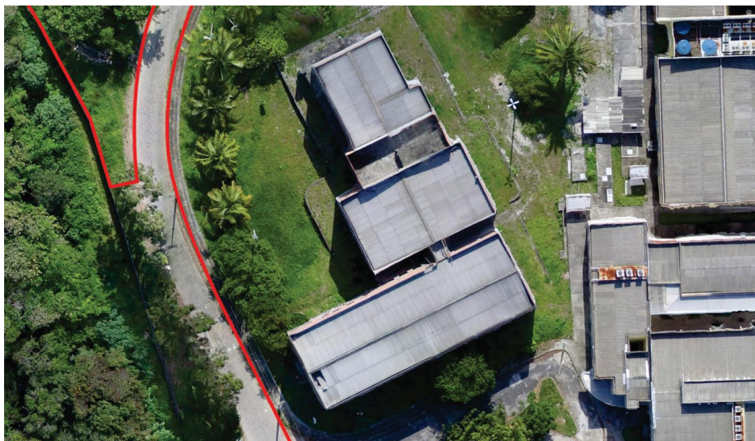
Imagem Aérea 01 – Departamentos DCF e DEA: Entorno / Terreno / Cobertura. Acervo Fotográfico: UFS / DOFIS / DIPRO – Divisão de Projetos.
